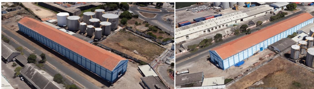
Figura 2 – Vista externa do Armazém 3B.
